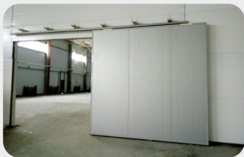
Plant «Amkodor Elastomer», Minsk region Retractable fireproof gates «FireDoors» Ei60
