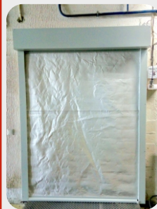
Plant «BellaPak», Minsk region Fire curtain «FireDoors» Ei120
