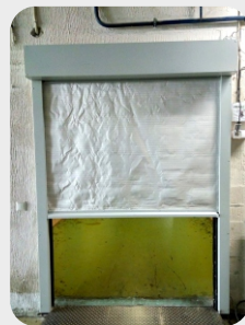
Plant «BellaPak», Minsk region Fire curtain «FireDoors» Ei120
