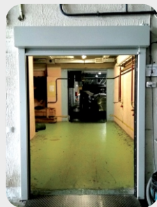
Plant «BellaPak», Minsk region Fire curtain «FireDoors» Ei120
