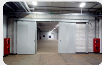
Warehouse of car's parts «MotorLand», Minsk Retractable fireproof gates «FireDoors» Ei60
