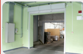
Фабрика «BelWoodDoors», Минск Противопожарные шторы «ФаерДорс» Ei120
