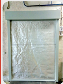
Завод «БеллаПак», Минск Противопожарная штора «ФаерДорс» Ei120
