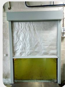
Завод «БеллаПак», Минск Противопожарная штора «ФаерДорс» Ei120
