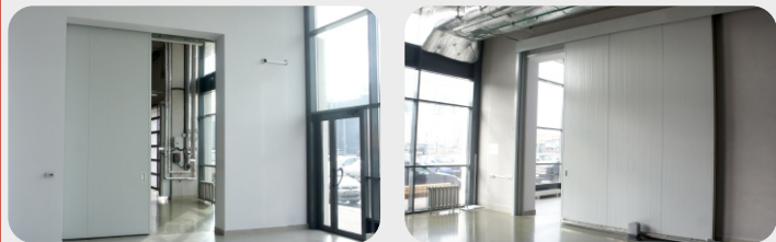
Автомобильный центр «Парад Авто», Минск Противопожарные откатные ворота «ФаерДорс» Ei60
