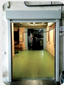
Завод «БеллаПак», Минск Противопожарная штора «ФаерДорс» Ei120
